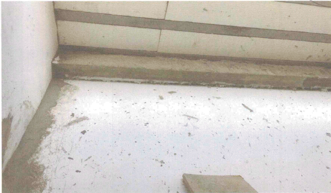
Foto 04: Viga e laje sofrendo flexão
